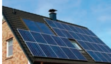
INSTALACIÓN DE PLACAS PARA AUTOCONSUMO
