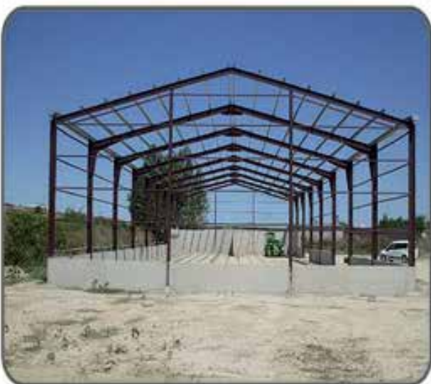
Almacén agrícola estructura metálica
